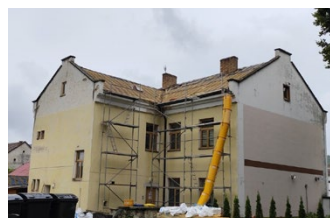
Výměna krytiny MT č. 2
